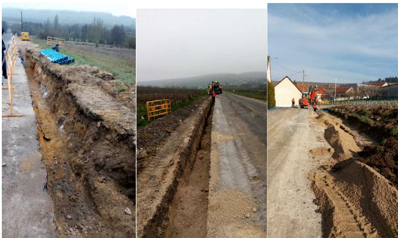
Vues du chantier des travaux d'interconnexion entre Leuvrigny et Festigny
